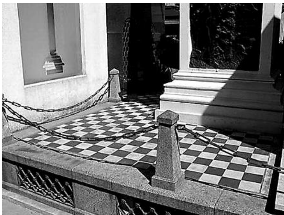
Figura 18. Pavimentos de Mosaicos, Cementerio de la Recoleta, Ciudad de Buenos Aires.
